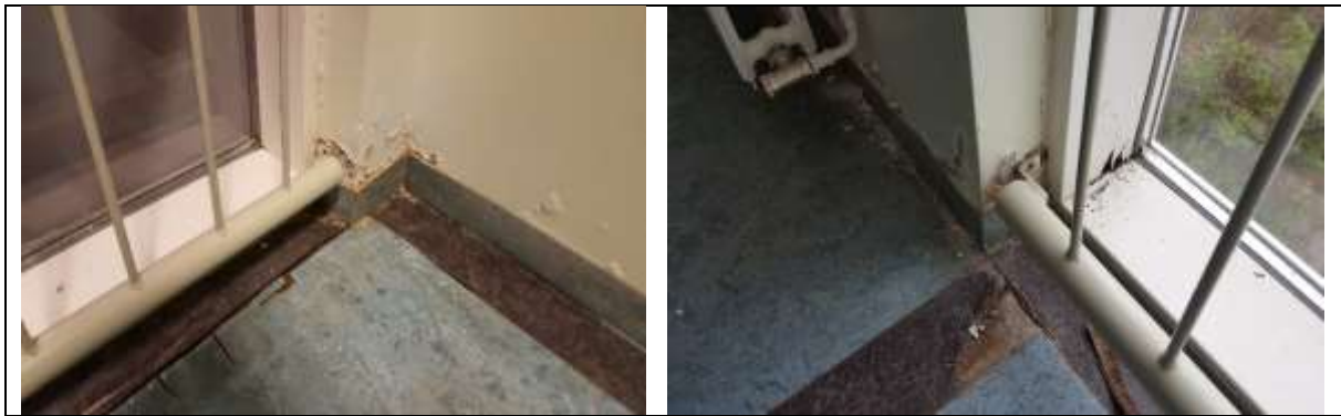
Mynd. Í setustofu má sjá töluverðar rakaskemmdir í vegg við glugga.
