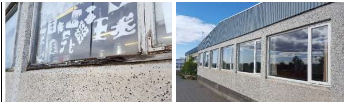
Mynd. Ástand glugga í D álmu sunnanmegin var ekki gott. Gluggar voru endurnýjaðir sunnanmegin.
