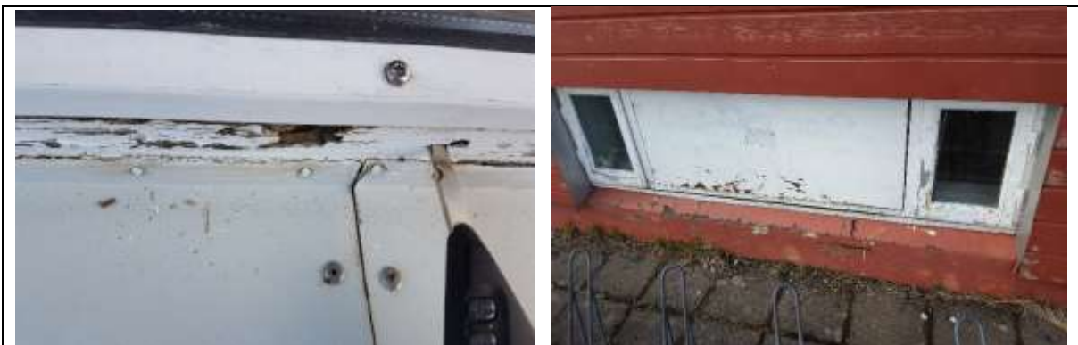
Mynd. Í B álmu eru kominn fúí í nokkra glugga og steypt vatnsbretti undir gluggum sprungin og laus.
