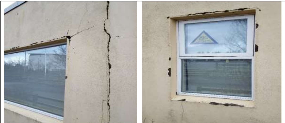
Mynd. Í E álmu eru komnar steypuskemmdir og kominn tími á endurmálun veggja.
