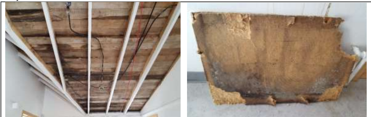
Mynd. Þegar loftplötur voru teknar niður kom í ljós töluverð mygla. Korkur var notaður sem einangrun en þegar hann var tekinn niður komu í ljós mygluð borð sem var einnig komin í burðarbita.
