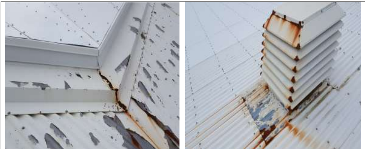
Mynd. Þakjárn þarf að endurmála og skipta út barðaventlum, öllum loftristum og flasningum og festingum að hluta.
