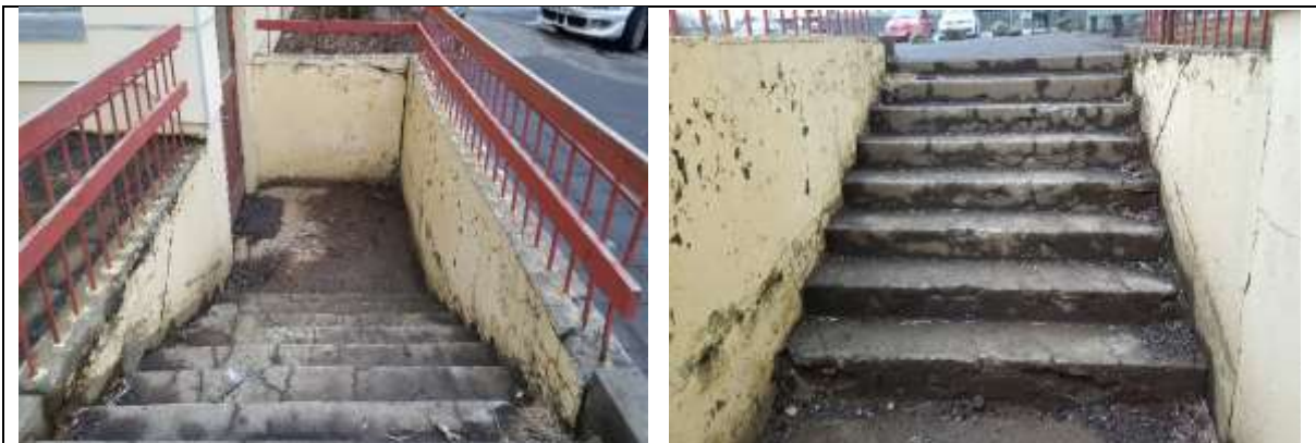
Mynd. Í B álmu eru veggir töluvert sprungnir og tröppur niður í kjallara orðnar illa farnar.
